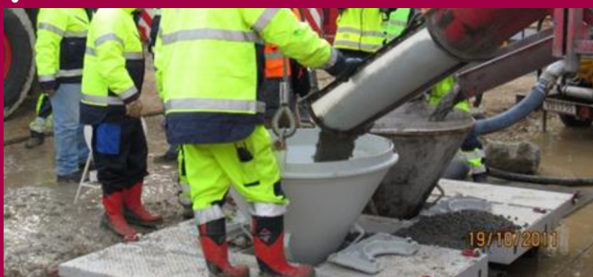
Foto: Støbning af panel gennem to tremmies.
