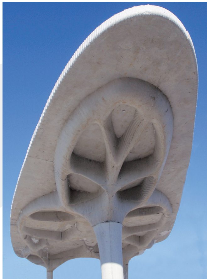
Lava beton® anvendt ved udstøbning af topologi-optimeret pavillon ifm. Unika-projektet
