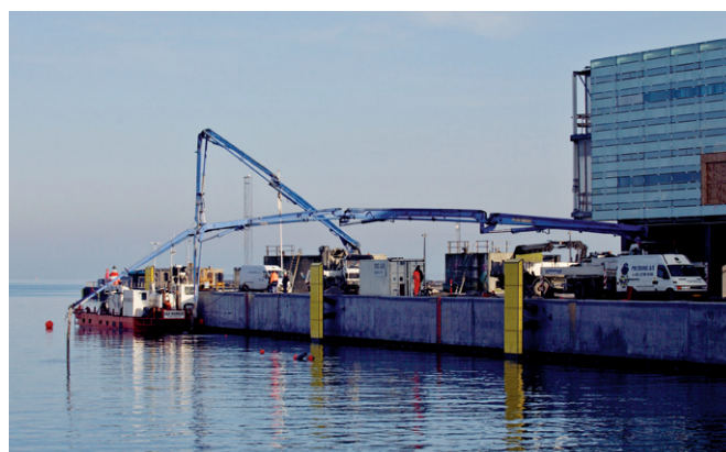
Støbning af terminalbund under vand med Lava beton® , Færgeterminal Nordhavn
